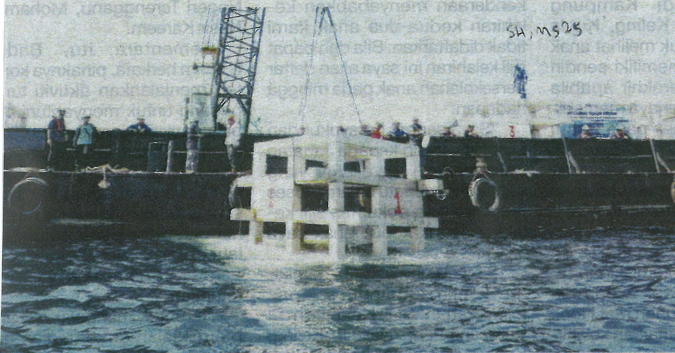
Pekerja melakukan kerja melabuh tukun tiruan jenis kuboid juvenil penghalang pukut tunda di perairan Taman Laut Pulau Kapas, Marang.
