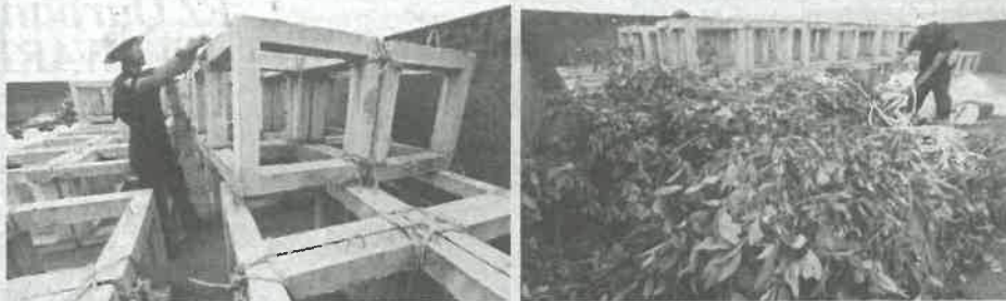
PEKERJA memeriksa tukun konkrit sebuah ditenggelamkan di perairan Kampung Mukut, Pulau Tioman menggunakan tongkang.
