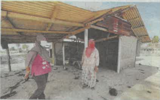
SITI KHADIJAH (kiri) meninjau keadaan bangsal ikan kering yang rosak akibat air pasang besar di Kampung Pantai Pachakan, Pasir Puteh semalam. – TOREK SULONG
